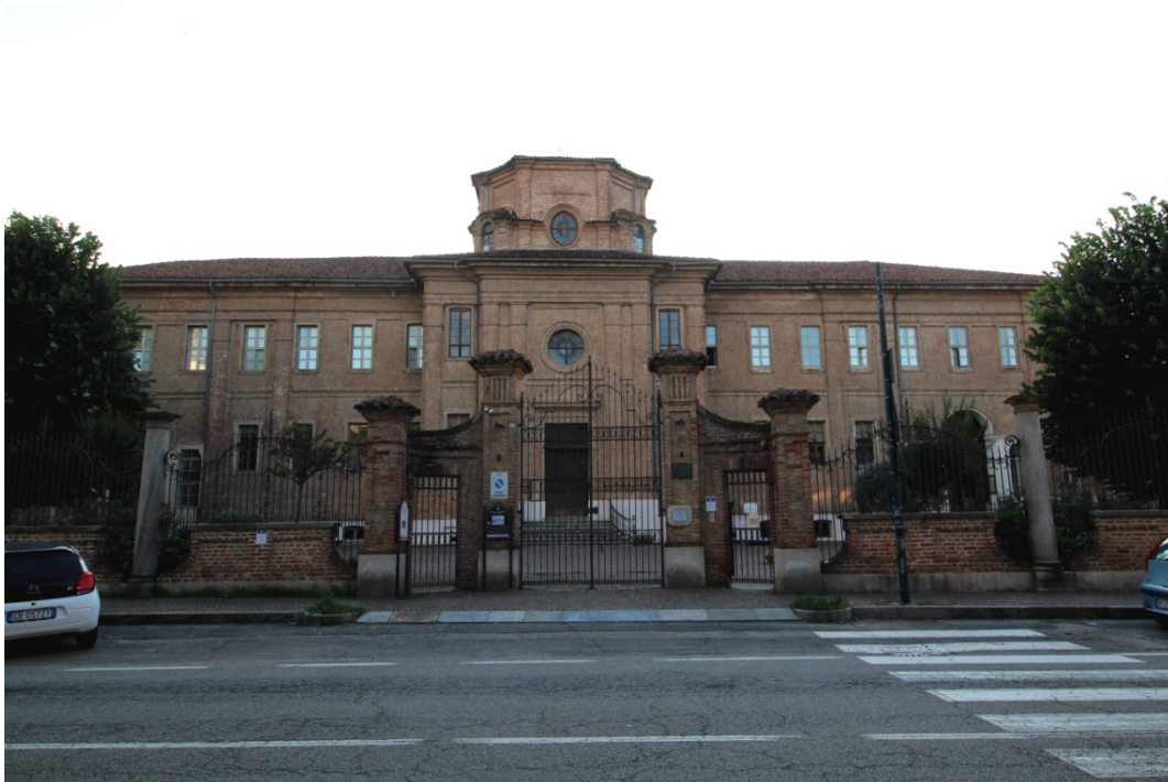
Veduta dell'edificio con la cancellata realizzata nel 1931
